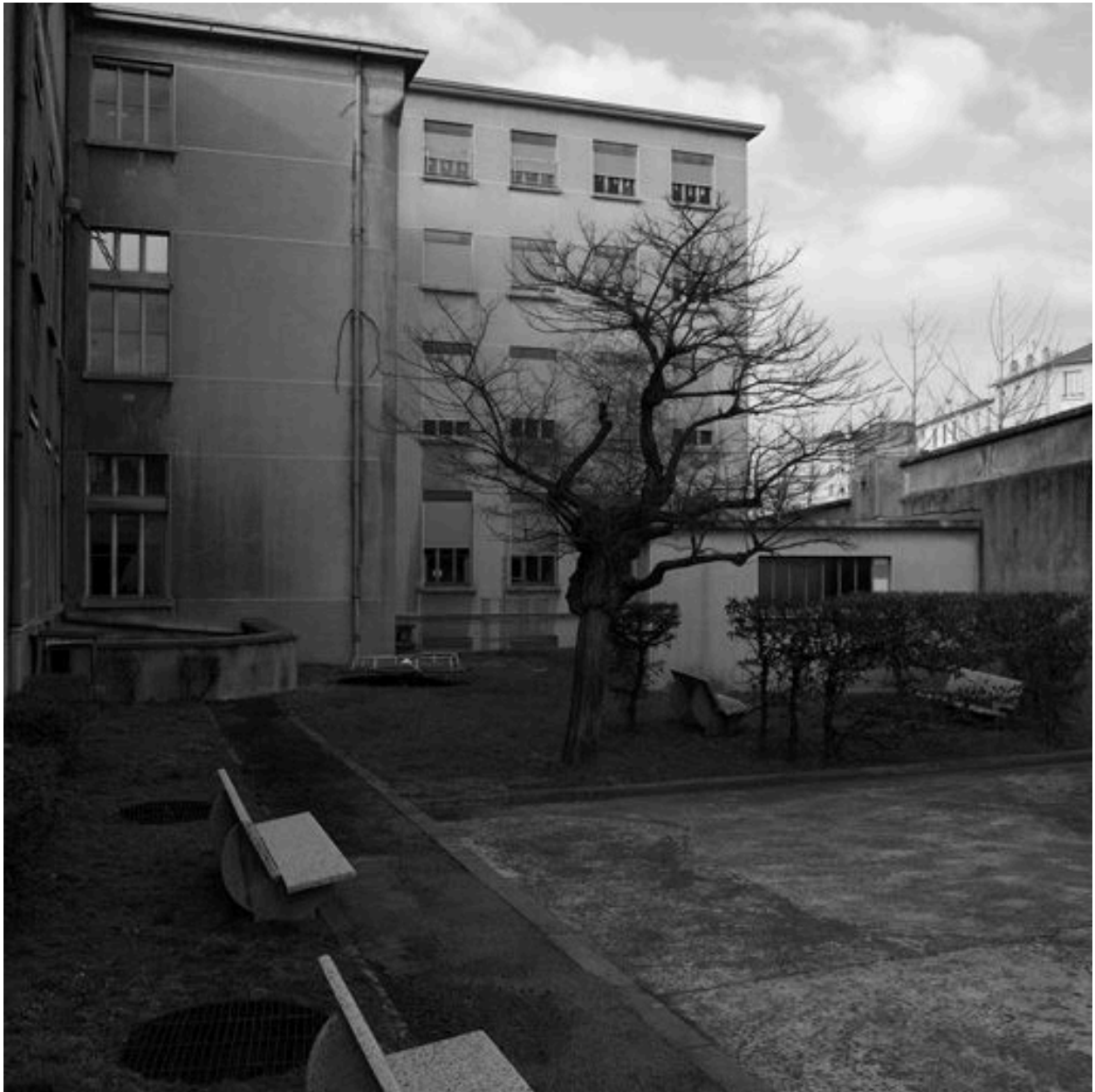
Le pavillon U, élévation nord en bordure de la rue Viala
