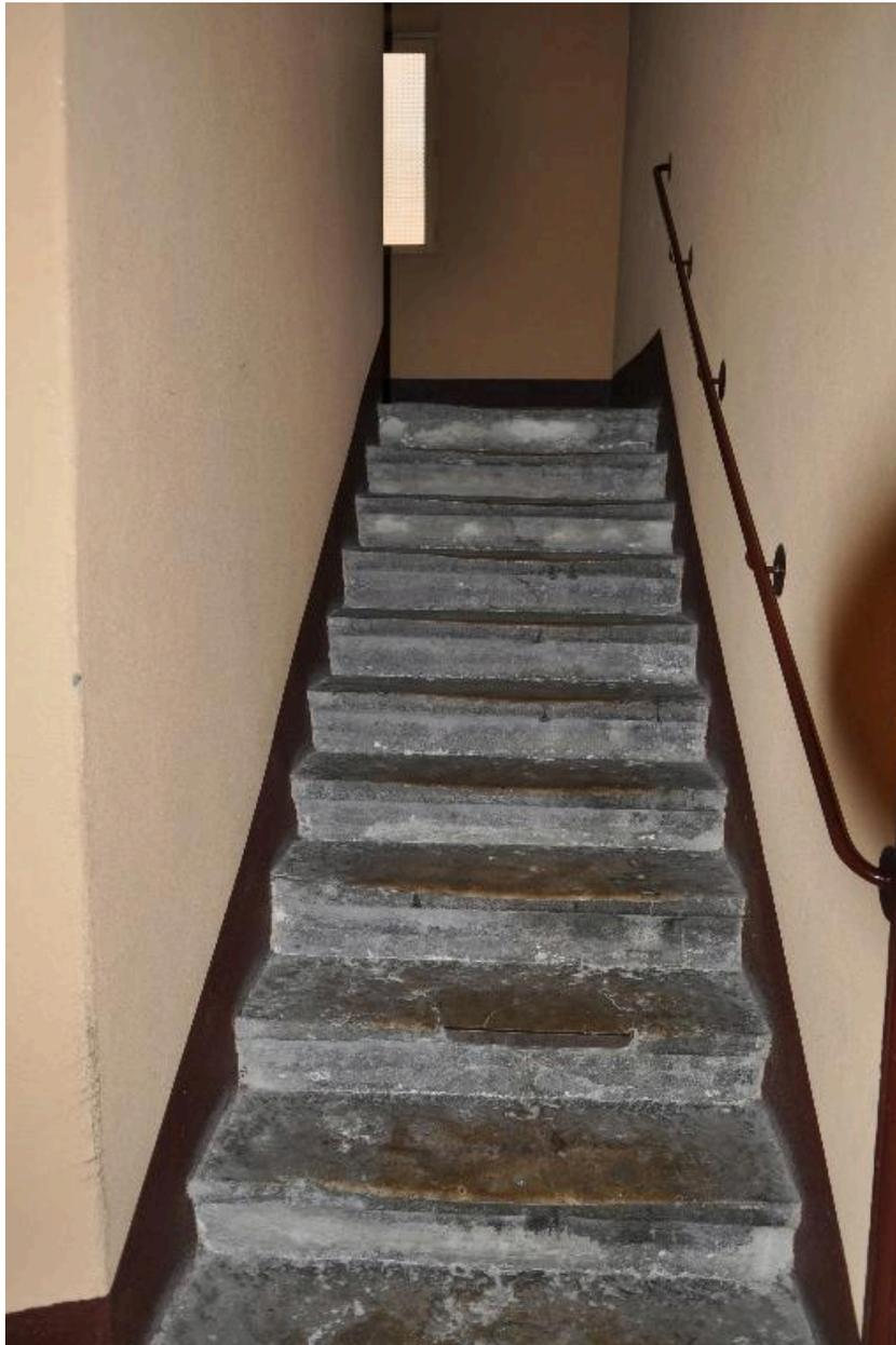
Vue d'une volée et du mur noyau plein de l'escalier du n°5 rue Dumenge
