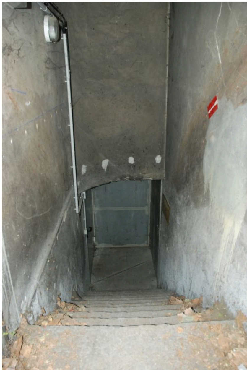
Vue sur l'escalier menant à la chaufferie
