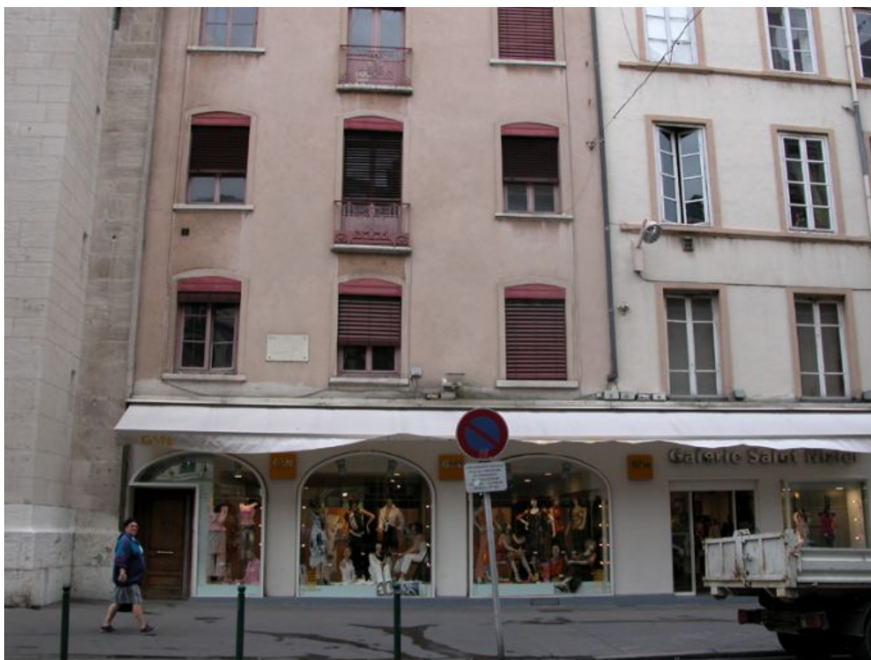
Façade principale, vue des 3 premiers niveaux
