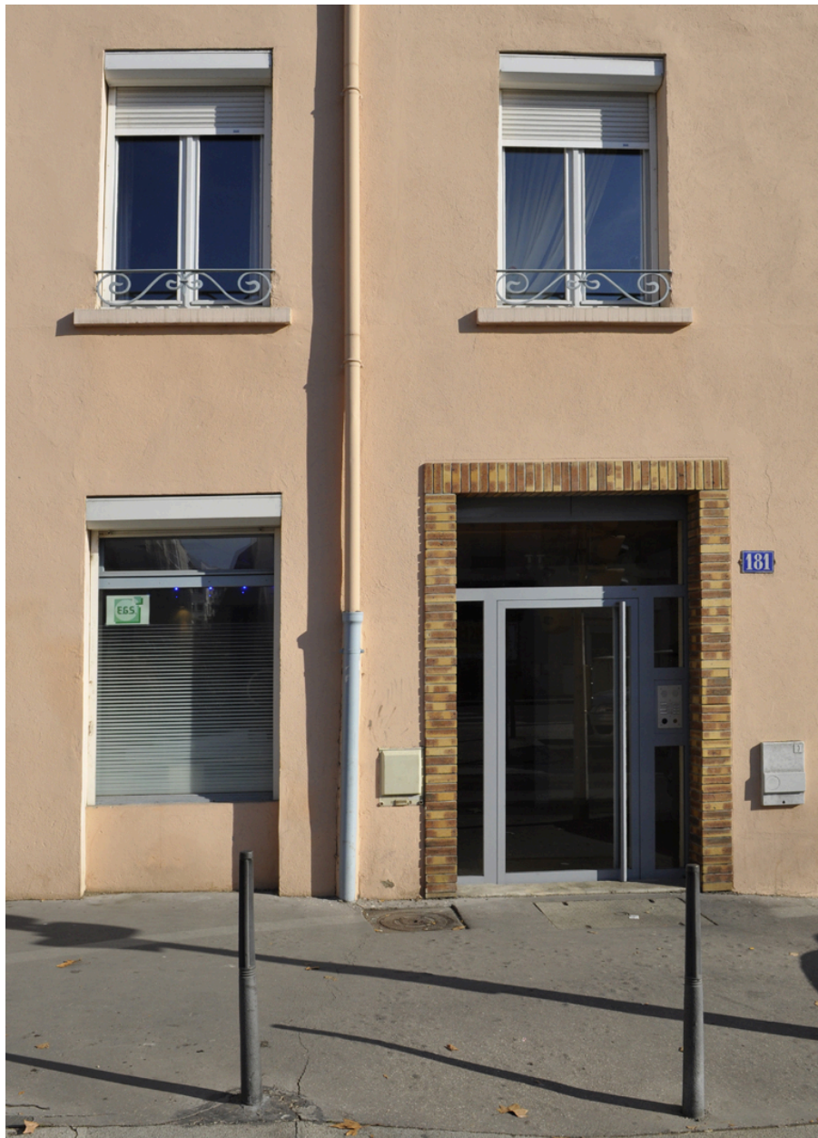
Elévation antérieure, Grande rue de la Guillotière, détail du premier niveau
