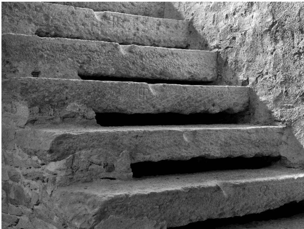
Détail des marches de l'escalier de la cave, marques de tâcherons
