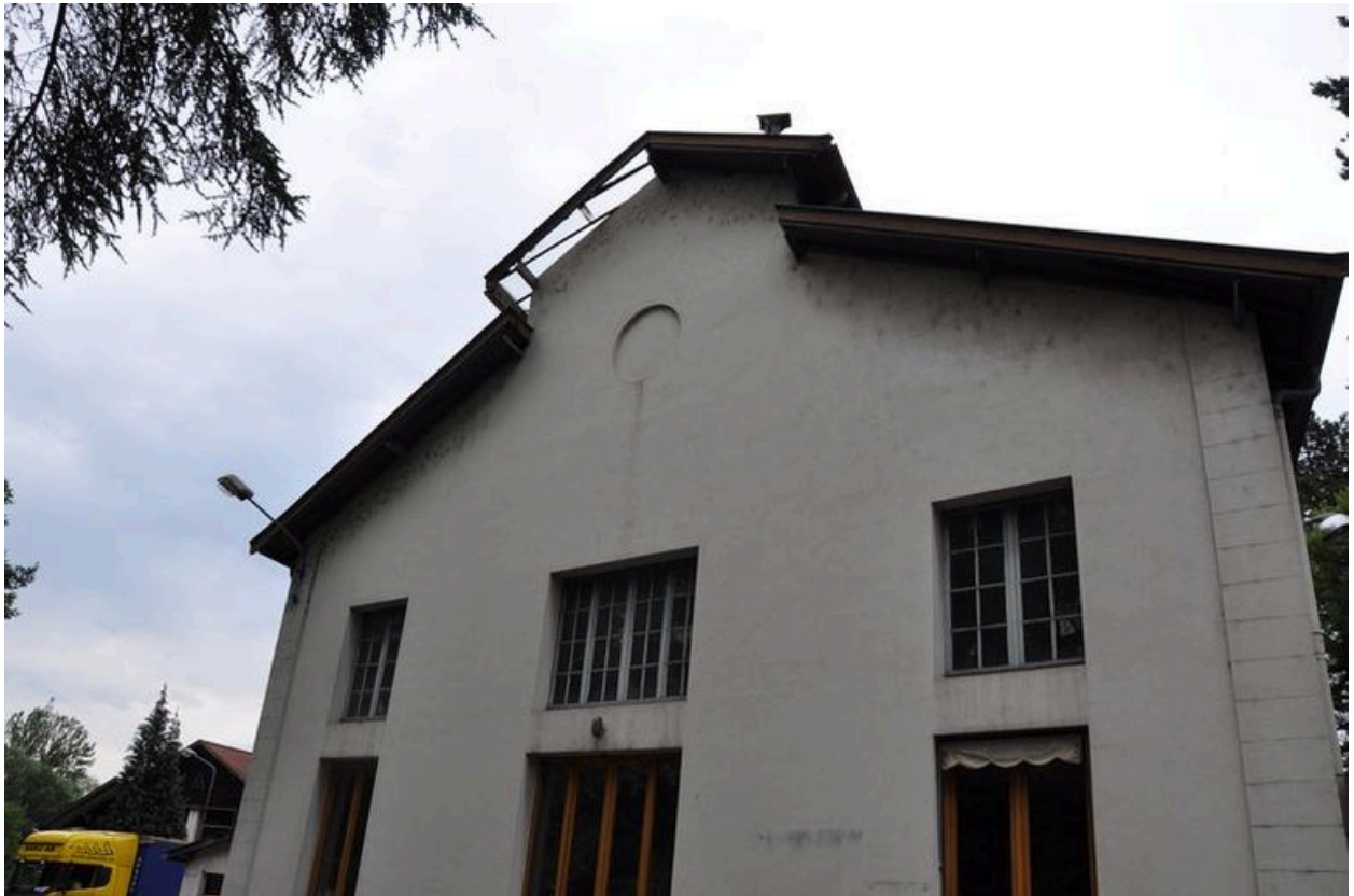
Mur pignon ouest des ateliers de laquage
