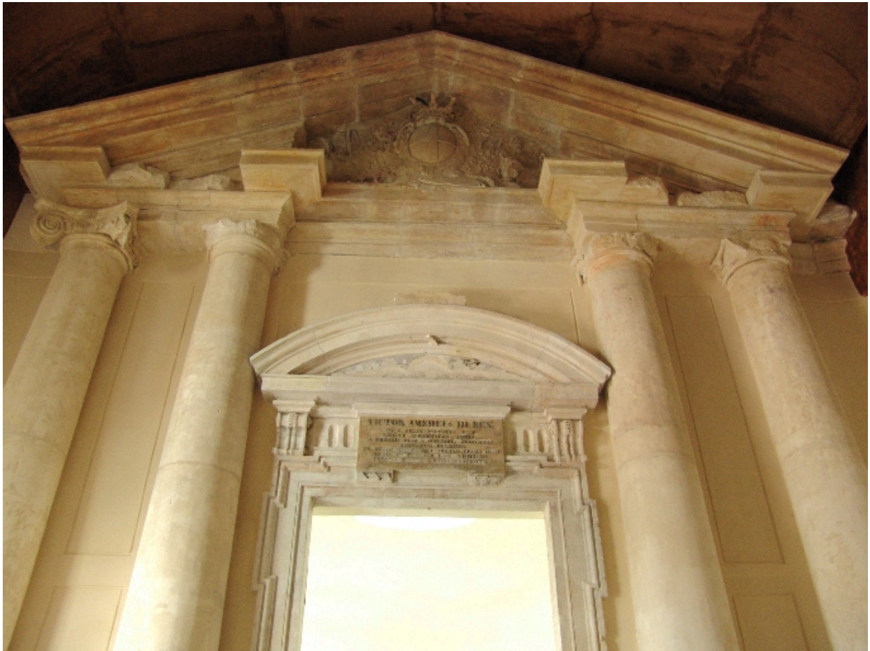
Façade du corps central après restauration
