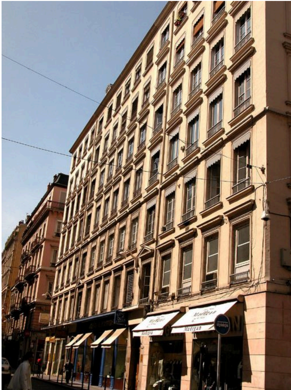
Vue d'ensemble avec les immeubles mitoyens (28 et 30 rue de Brest)
