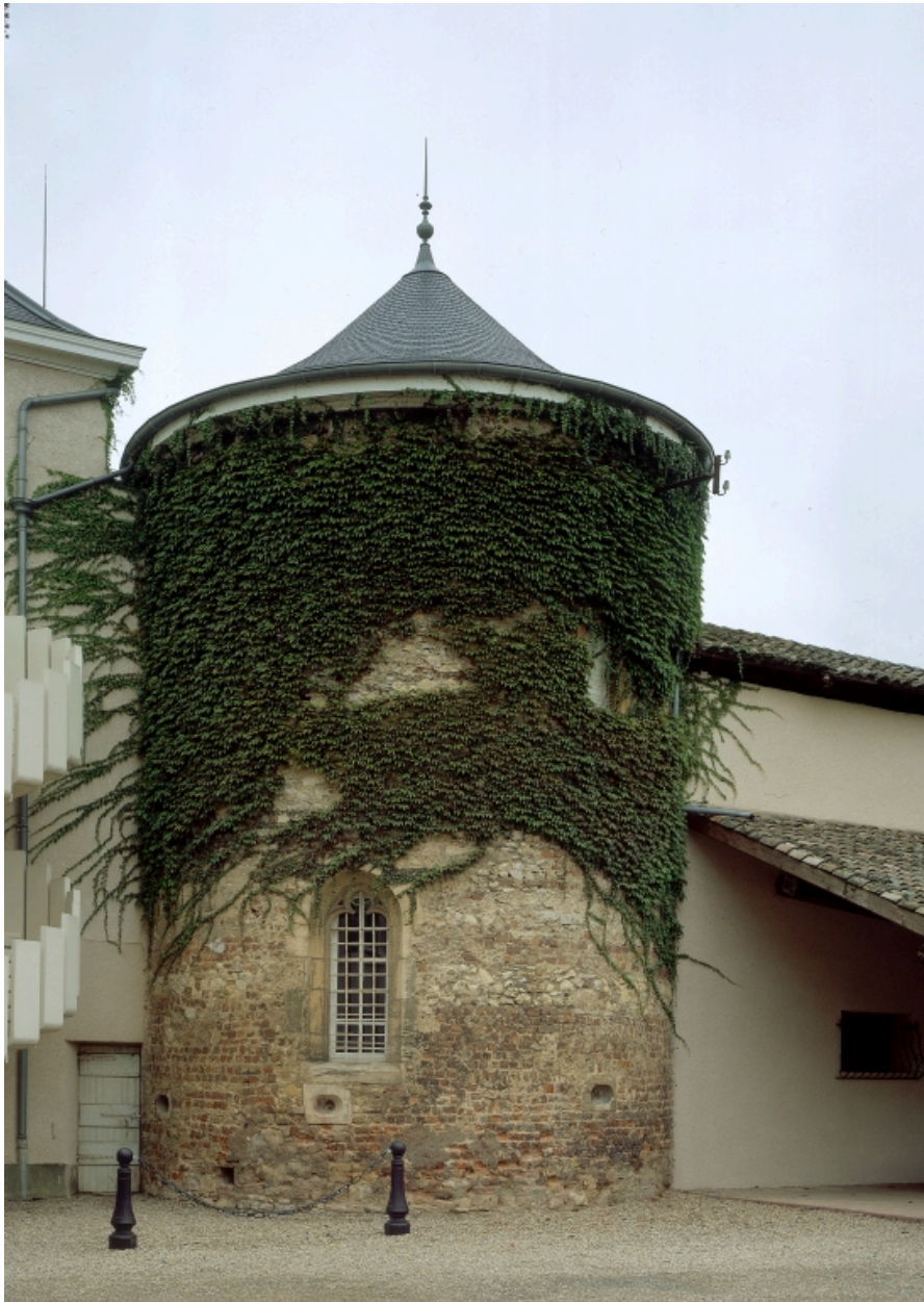
Tour sur l'élévation postérieure (ancienne chapelle).
