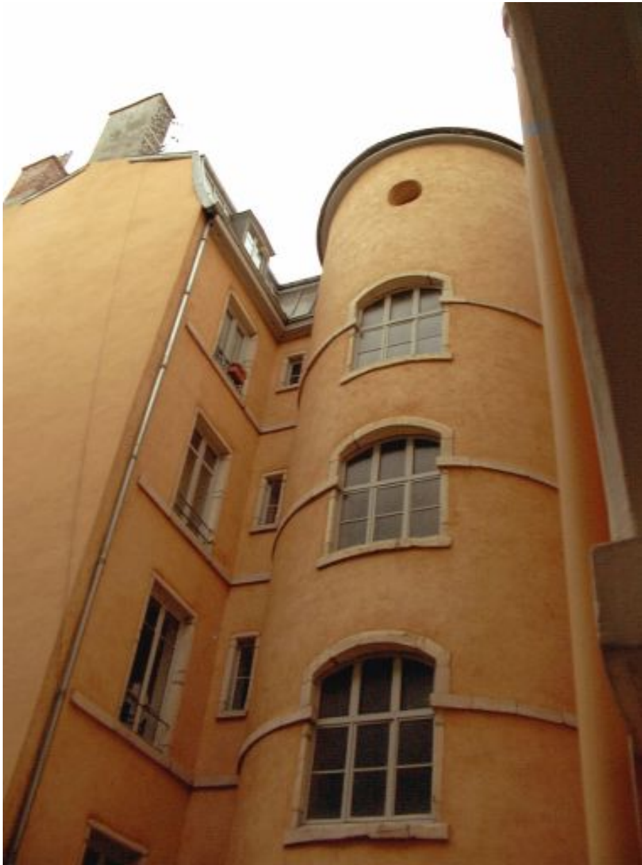
Vue des étages de la tour d'escalier
