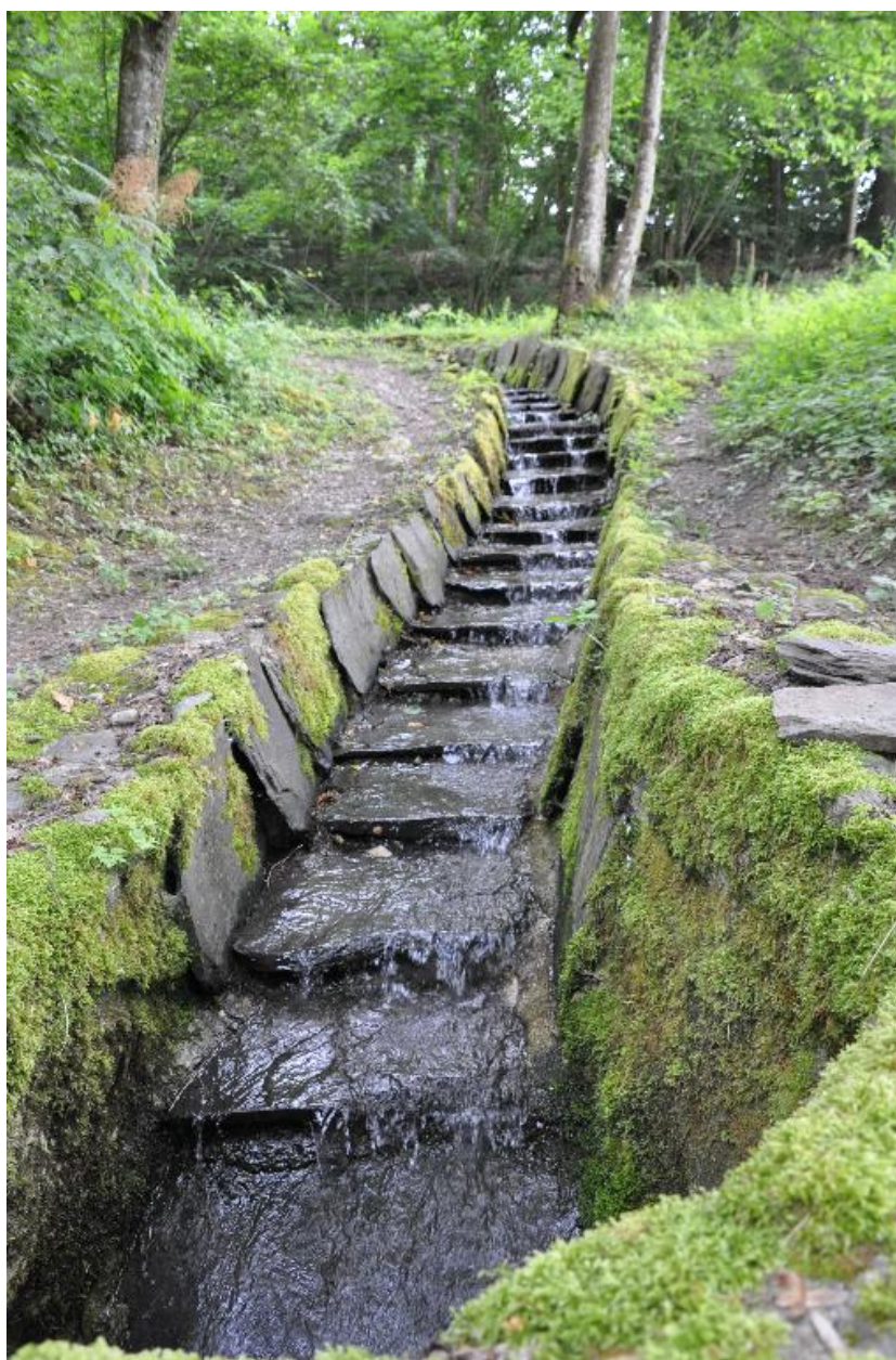
Canal d'amenée du moulin.
