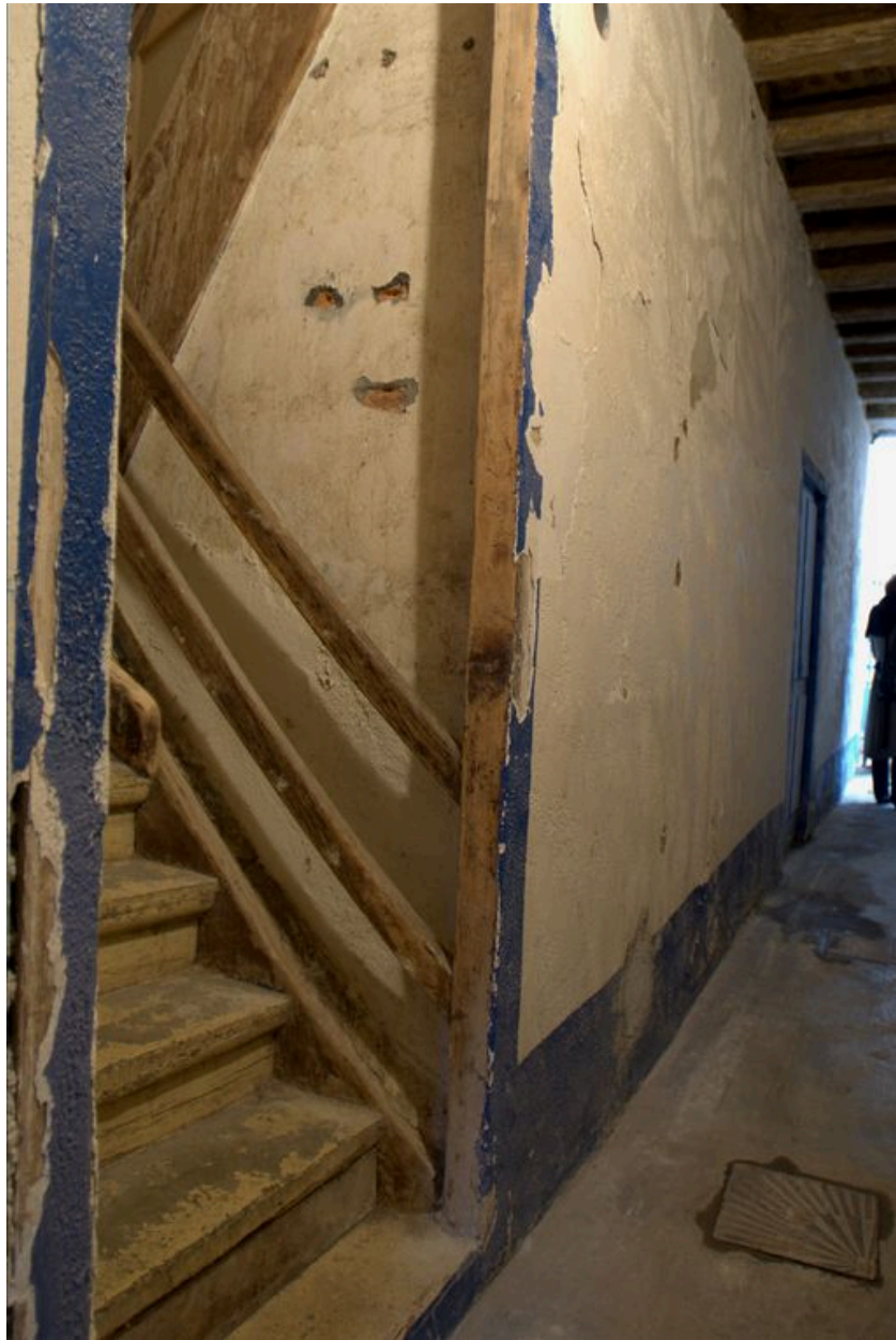
Le départ de l'escalier
