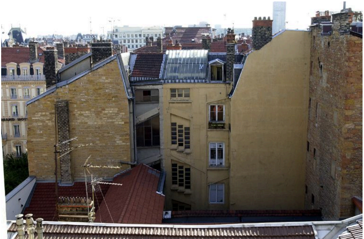
Elévations postérieures depuis la cage d'escalier de l'immeuble sis 23 rue de Brest
