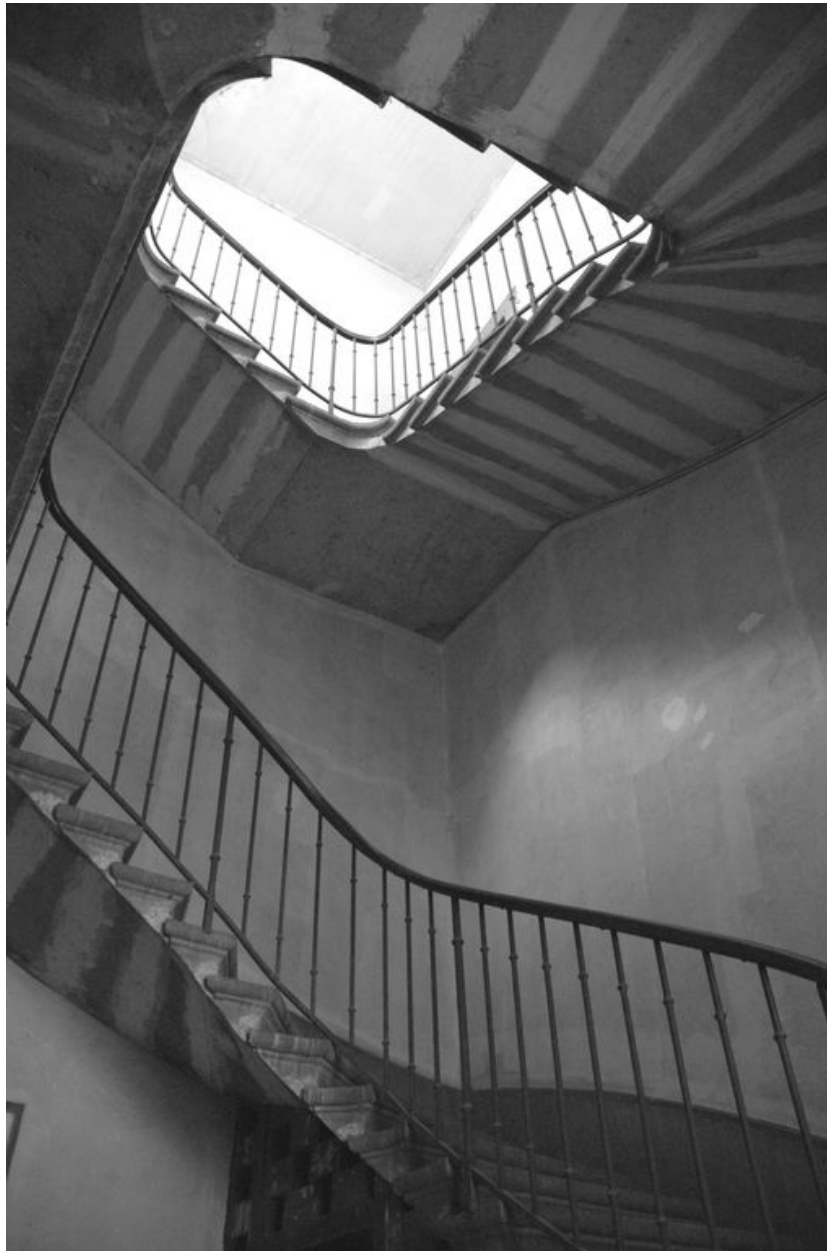
Bâtiment de la galerie, cage d'escalier
