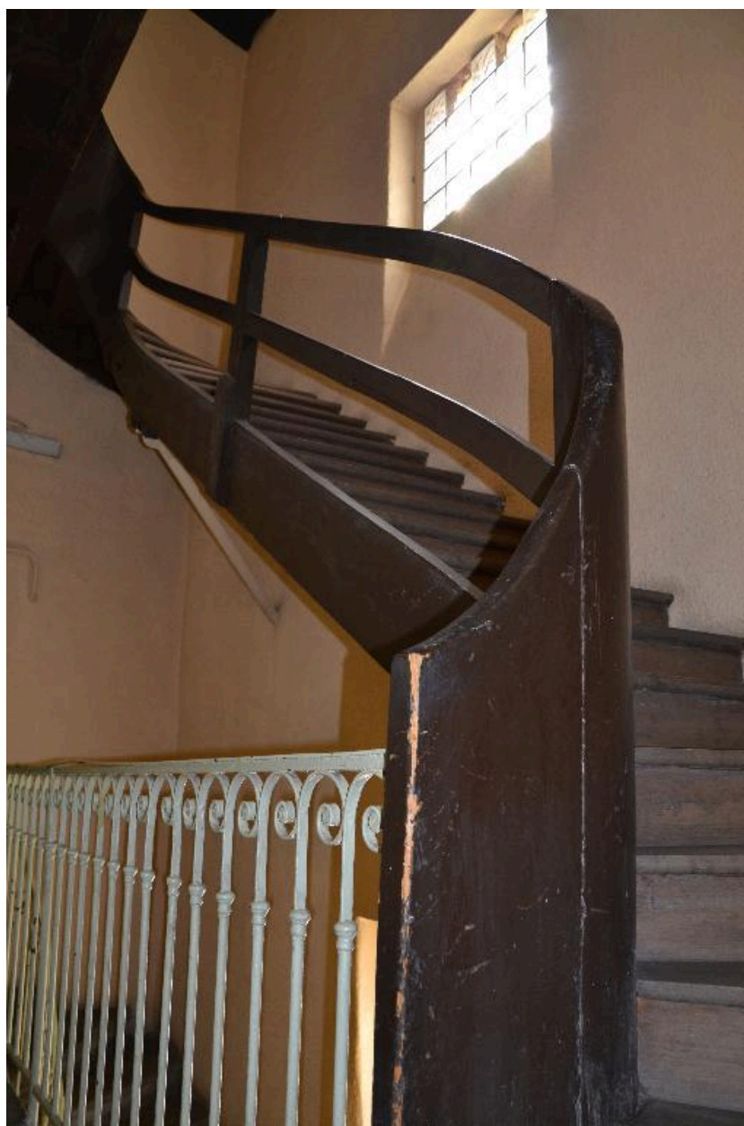
Escalier dernier niveau
