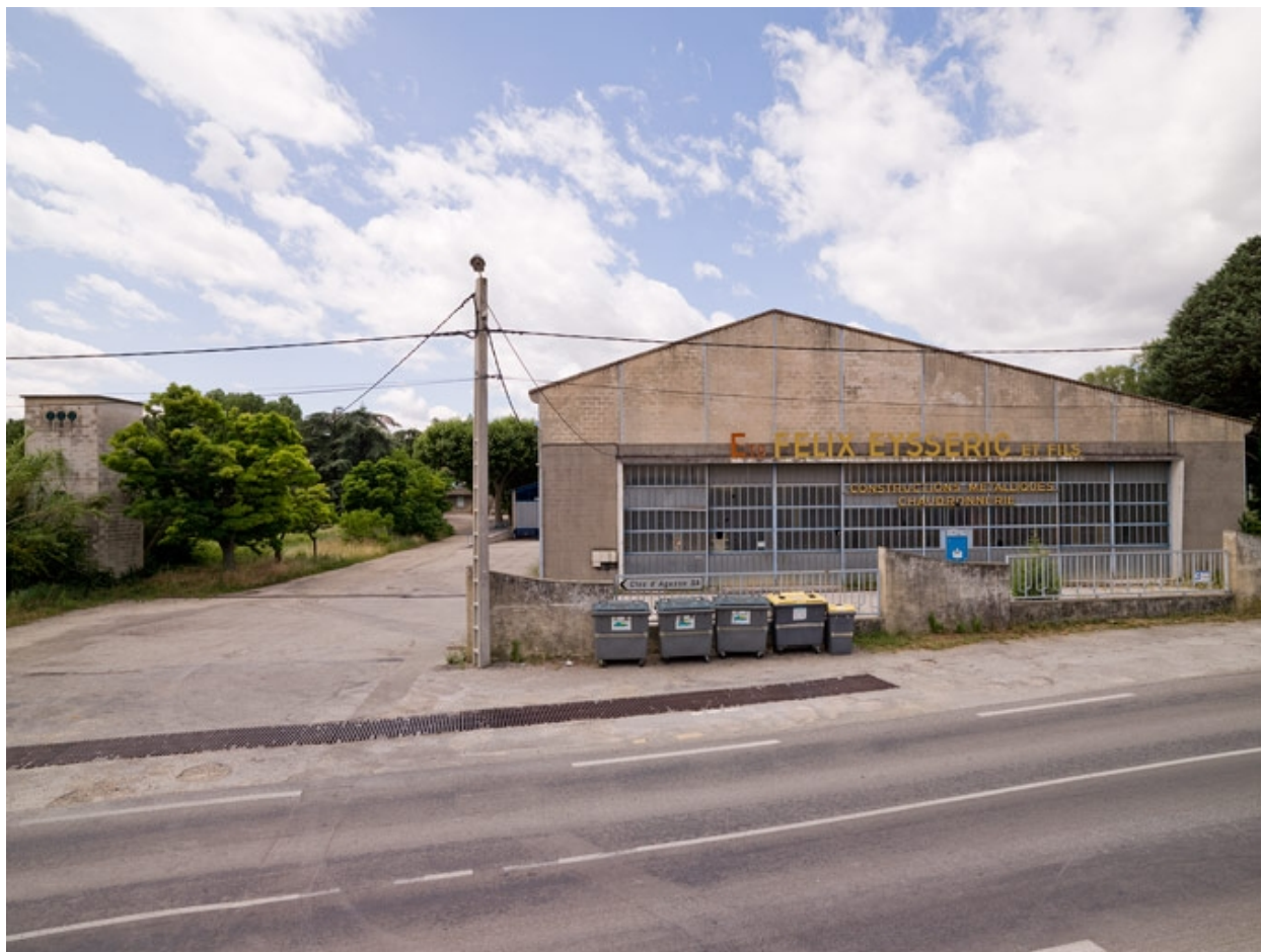
Vue générale Nord
