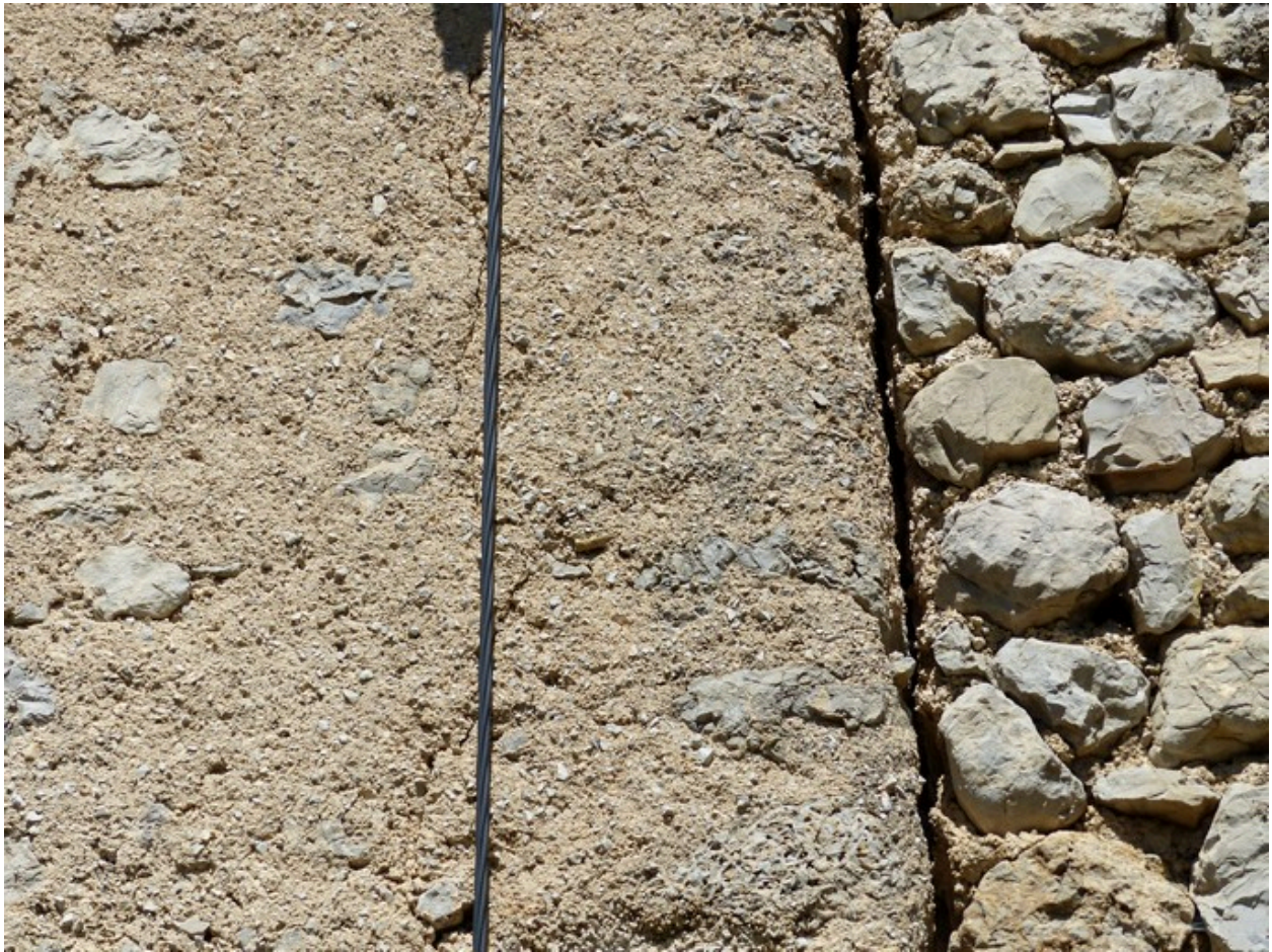
Enduit rustique et collage de maçonnerie, ferme au quartier du Vallon de Baïs.
