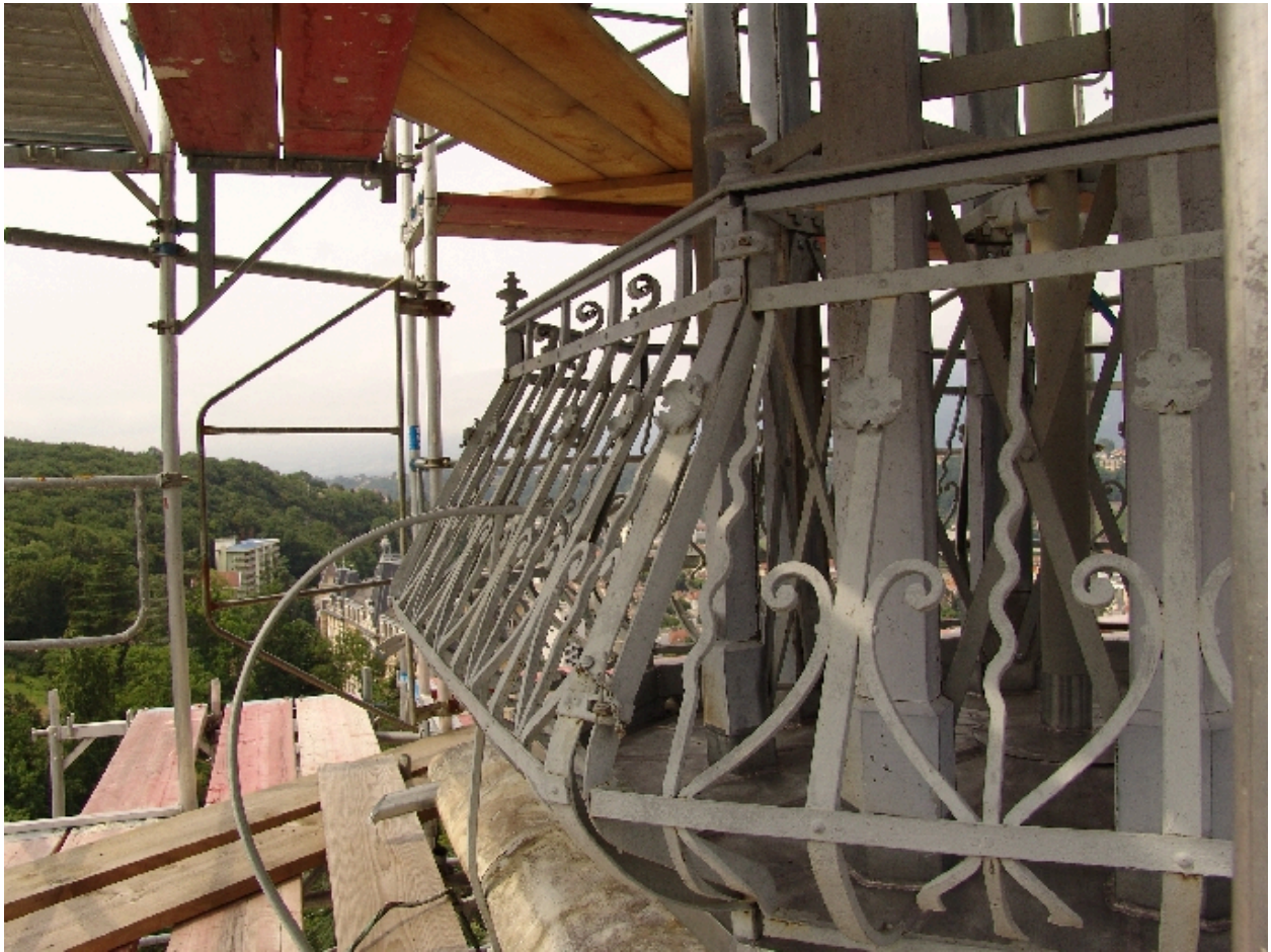
Garde-corps du lanternon
