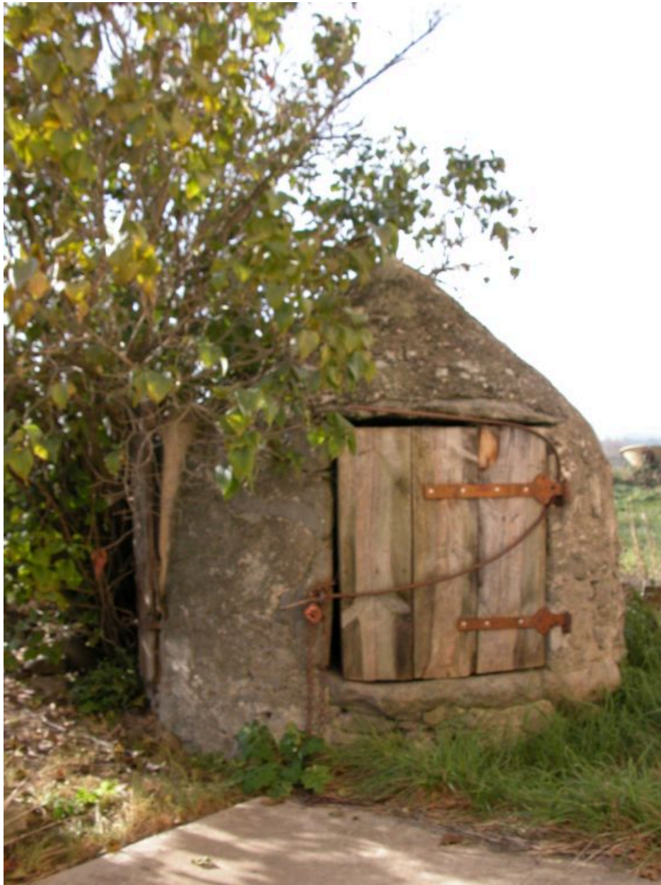
Vue d'ensemble du puits obus.
