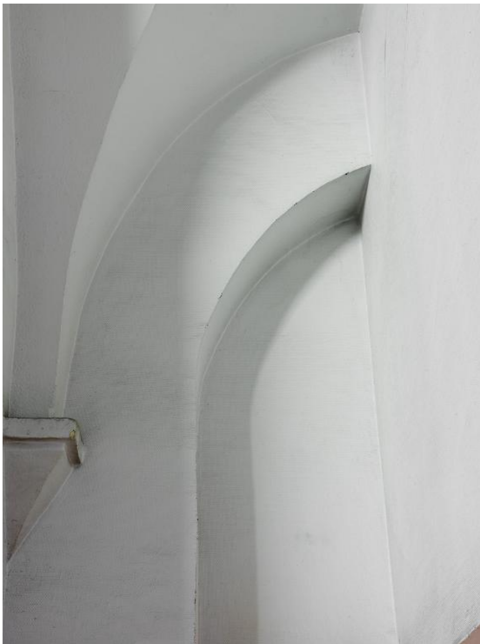
Vestibule de l'ancien tribunal des Prud'hommes, donnant sur l'escalier E, détail de la voûte
