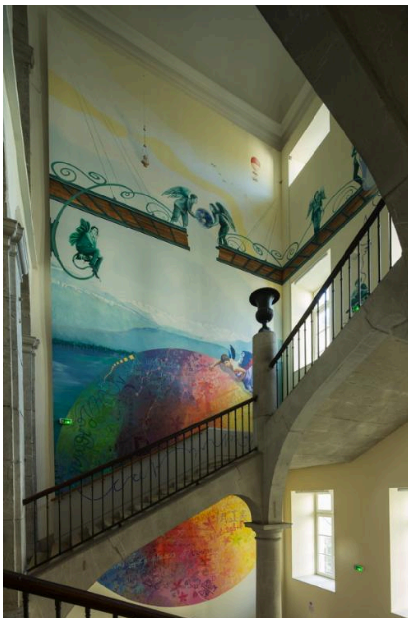
Escalier d'honneur, rampants portés sur la colonne d'angle intérieure.
