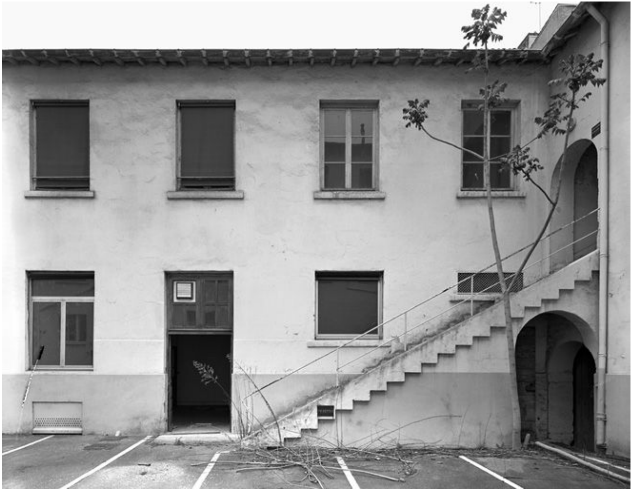
Cour 005, escalier à l'angle du corps central et du corps de liason nord
