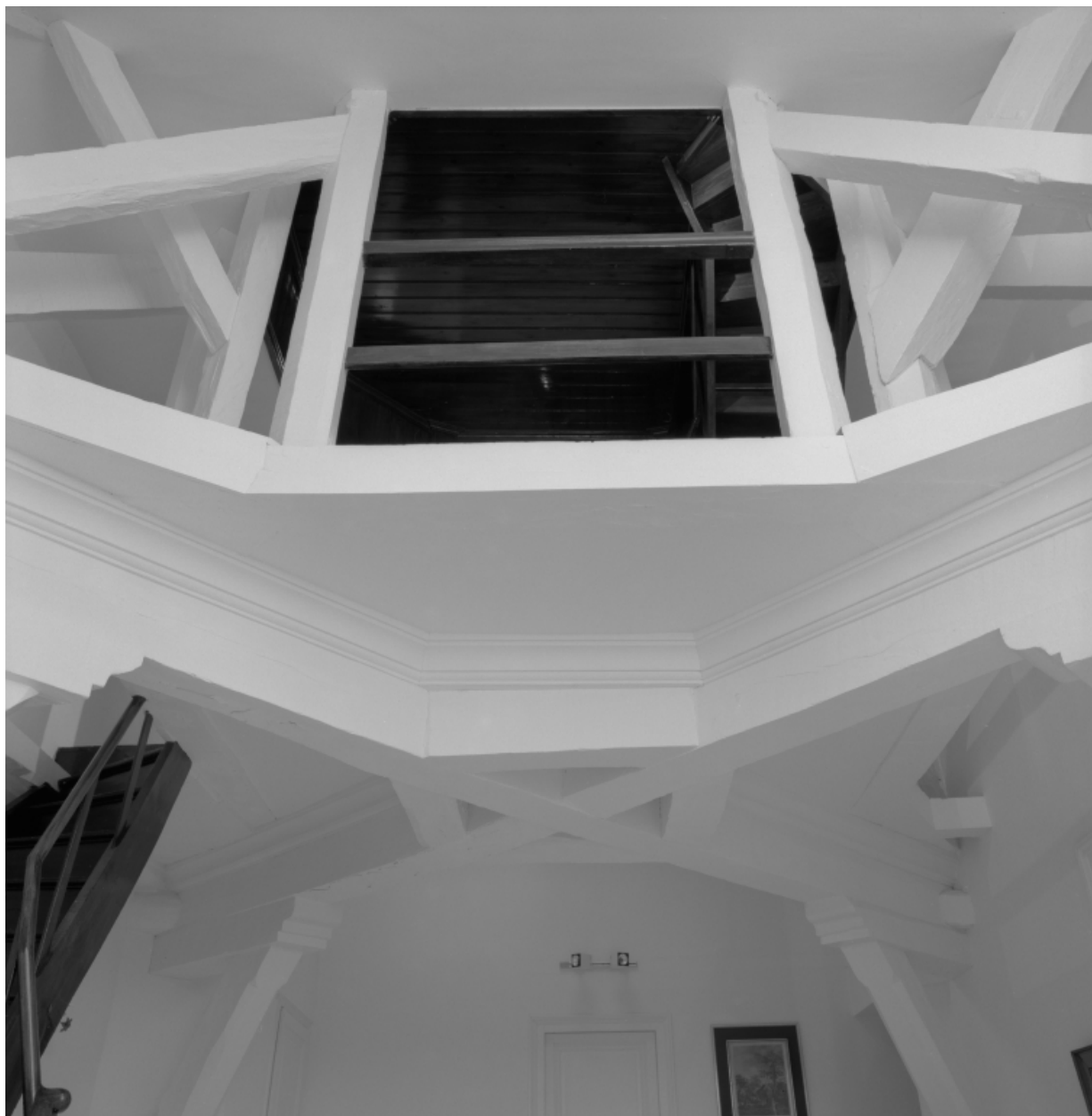
Etage de comble : vue de l'enrayure portant le belvédère.
