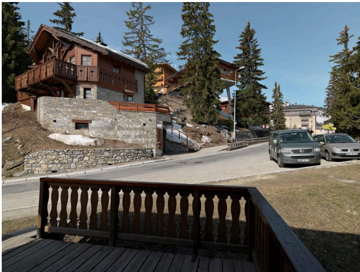
Le chalet dans son site depuis le sud-est
