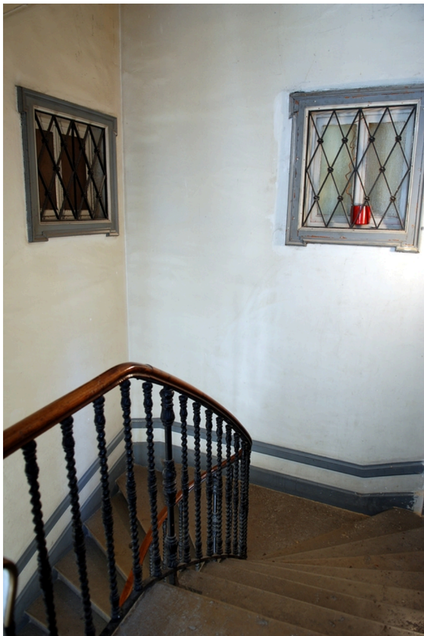
Corps de bâtiment ouest : cage d'escalier et fenêtres de second jour
