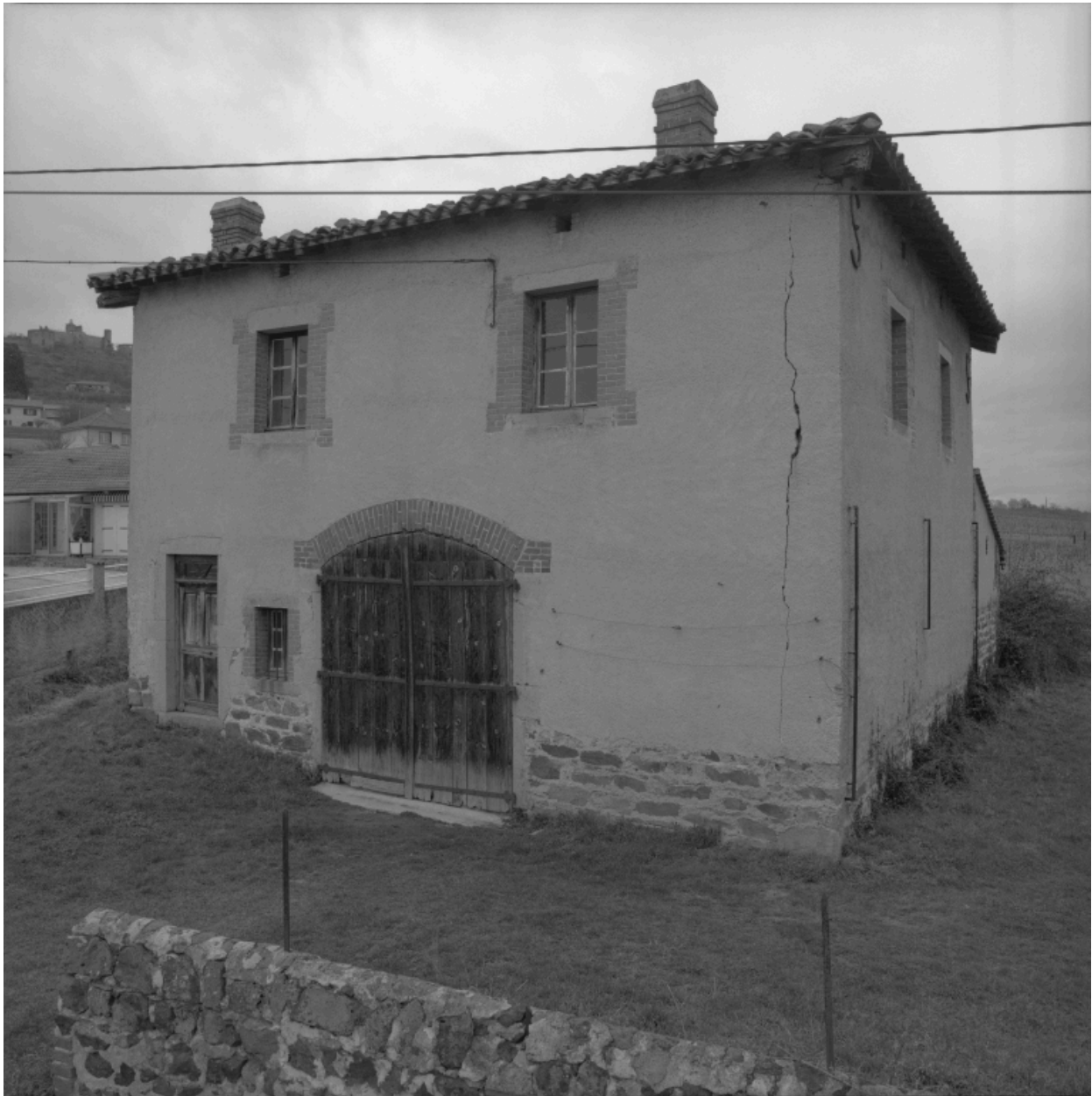
Marcilly-le-Châtel, le Ravat, parcelle 1987 A1 199. Vue d'ensemble de trois quarts droit.
