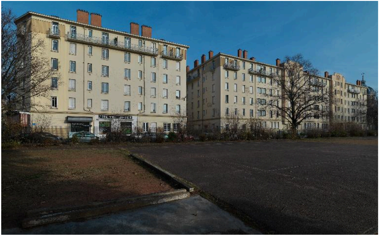
Vue d'ensemble des façades rue Marie-Anne-Leroudier depuis le stade Roger-Duplat
