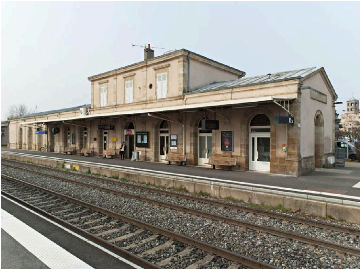
Vue générale de la gare d'Issoire, côté voies.
