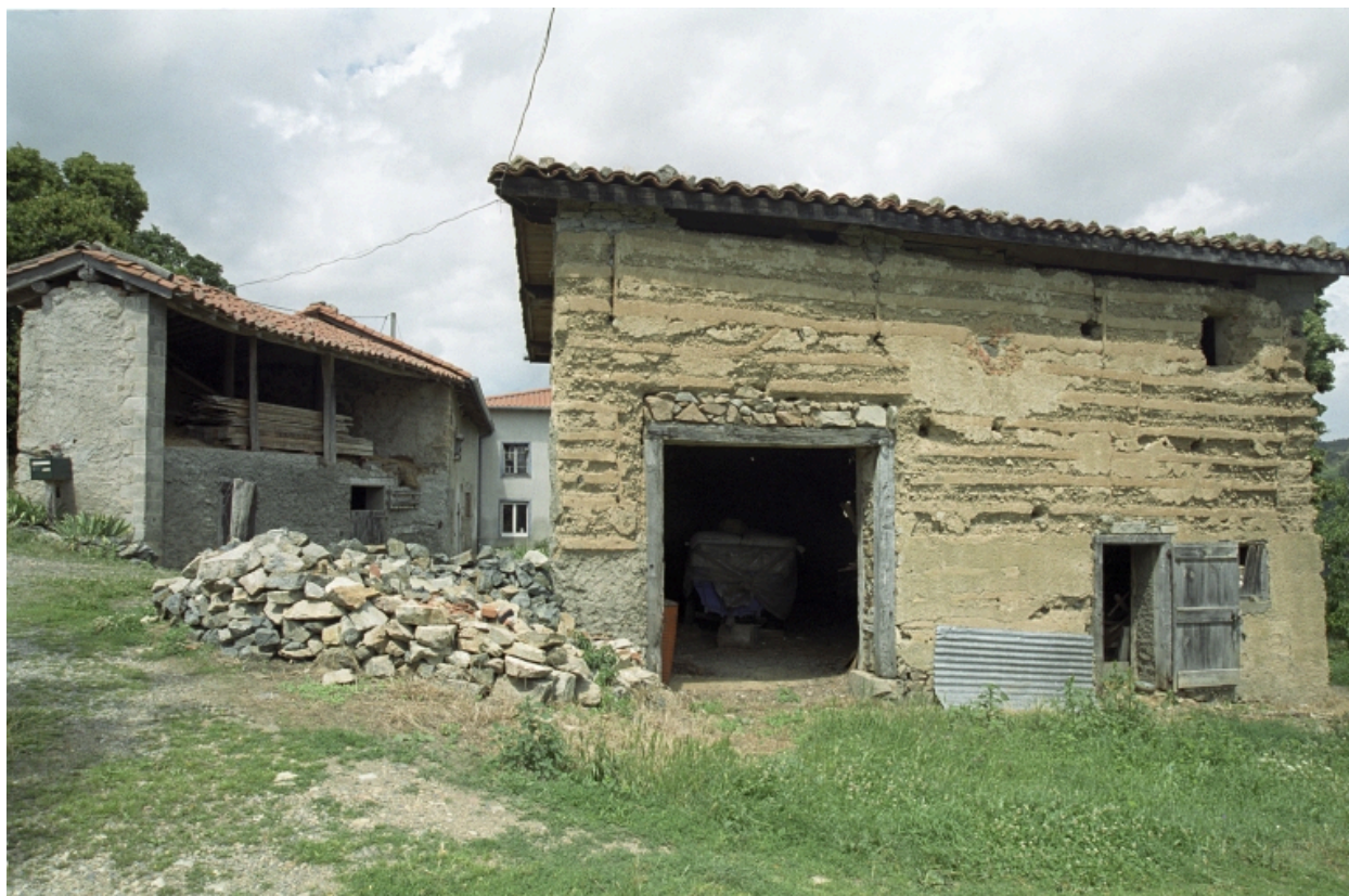
Saint-Laurent-Rochefort, Serre (1987 A2 1301), type B1. Vue d'ensemble du cuvage.
