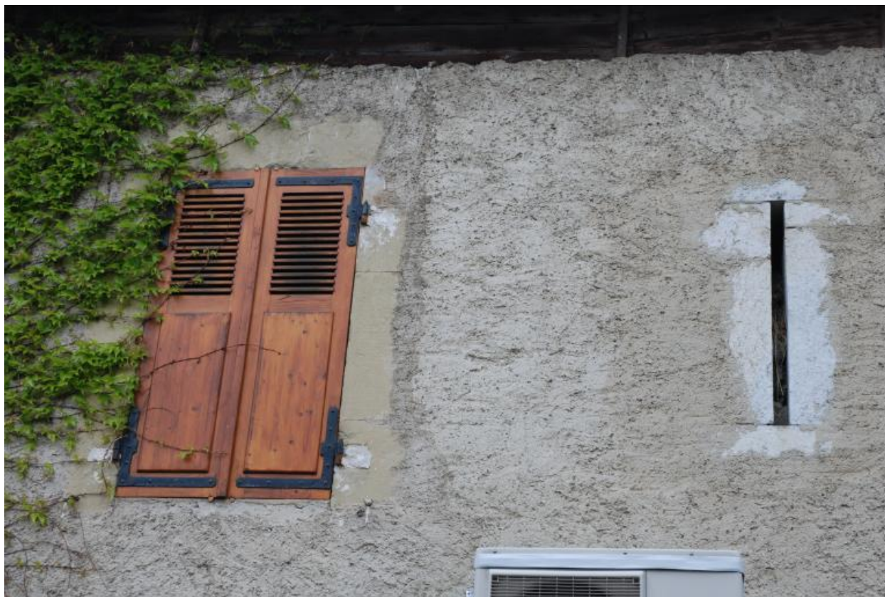
Détail de l'élévation postérieure : jour de placard garde-manger.
