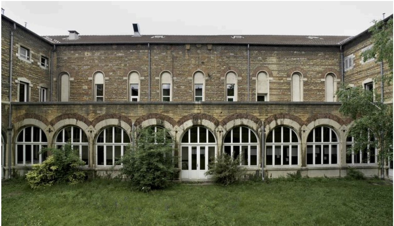
Cloître, élévation est, vue d'ensemble
