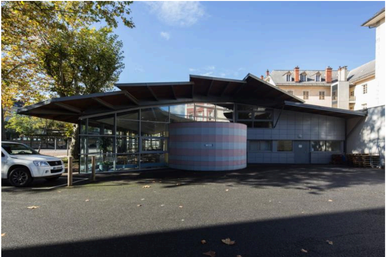
Espace Pierre-Balmain, façade sud.
