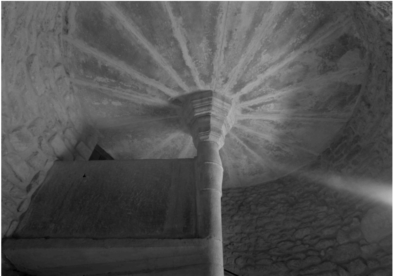
Escalier en vis, couverture en voûte plate tournant sur le noyau.
