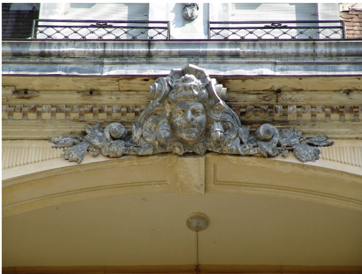
Façade nord-ouest : décor
