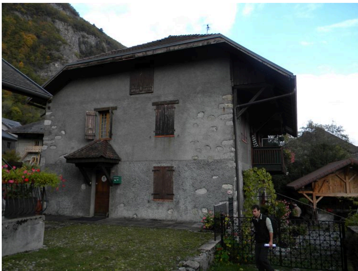
Vue du pignon ouest.
