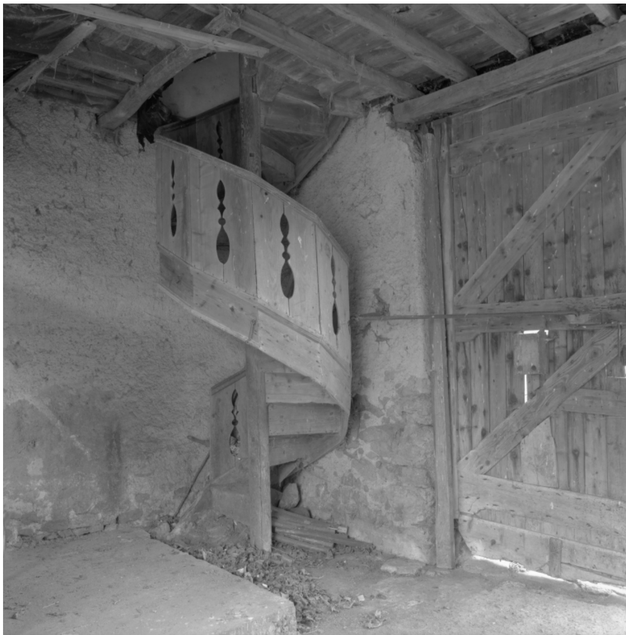
Escalier d'accès à la chambre située sur le passage couvert.
