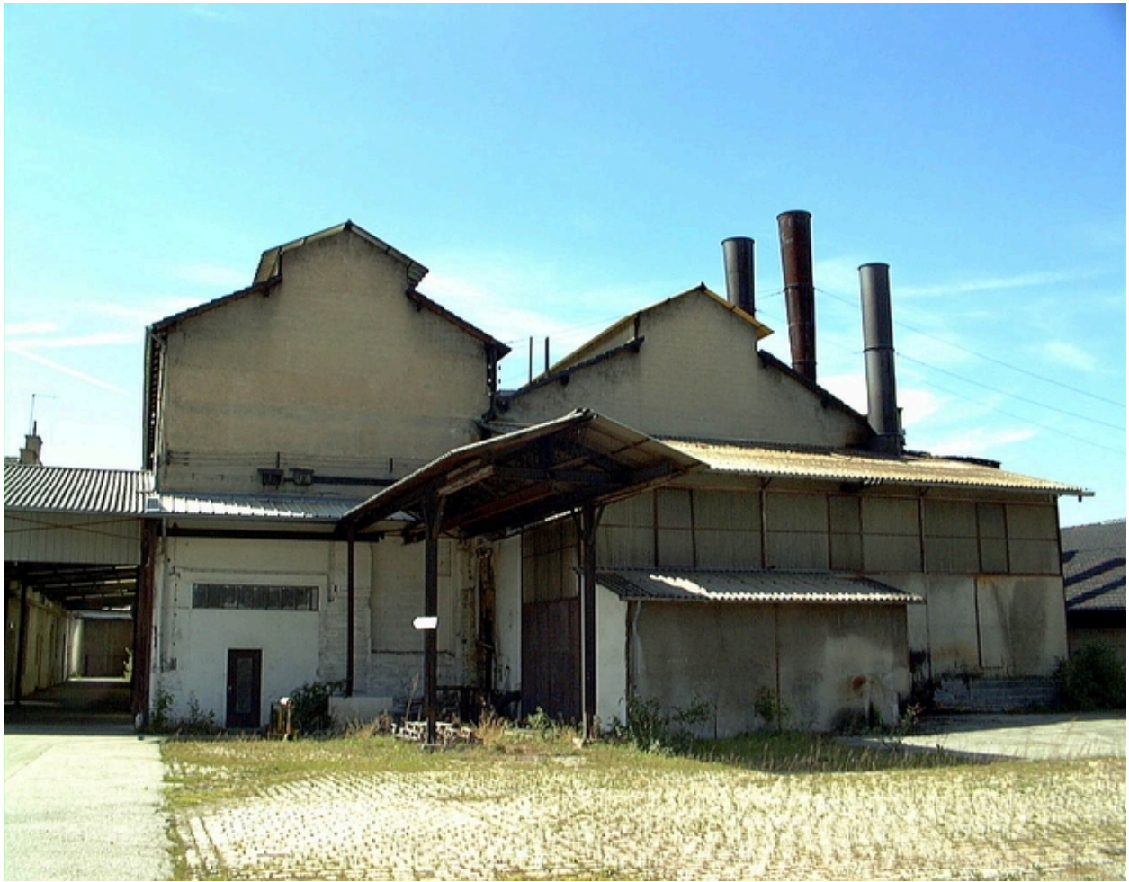
Vue générale est de l'usine : cheminées et lanterneaux
