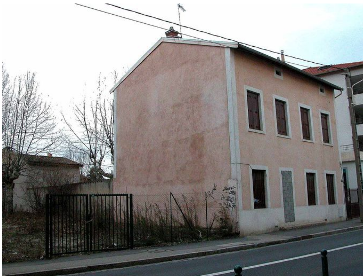
Vue générale depuis la rue, côté ouest
