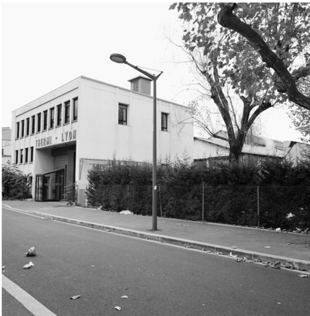
Vue ouest, bureaux, administration
