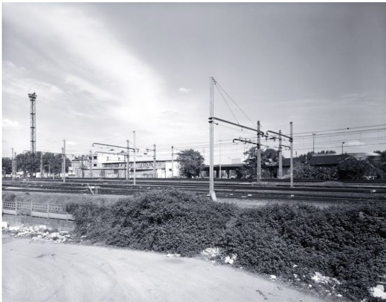
Elévation postérieure depuis la voie ferrée
