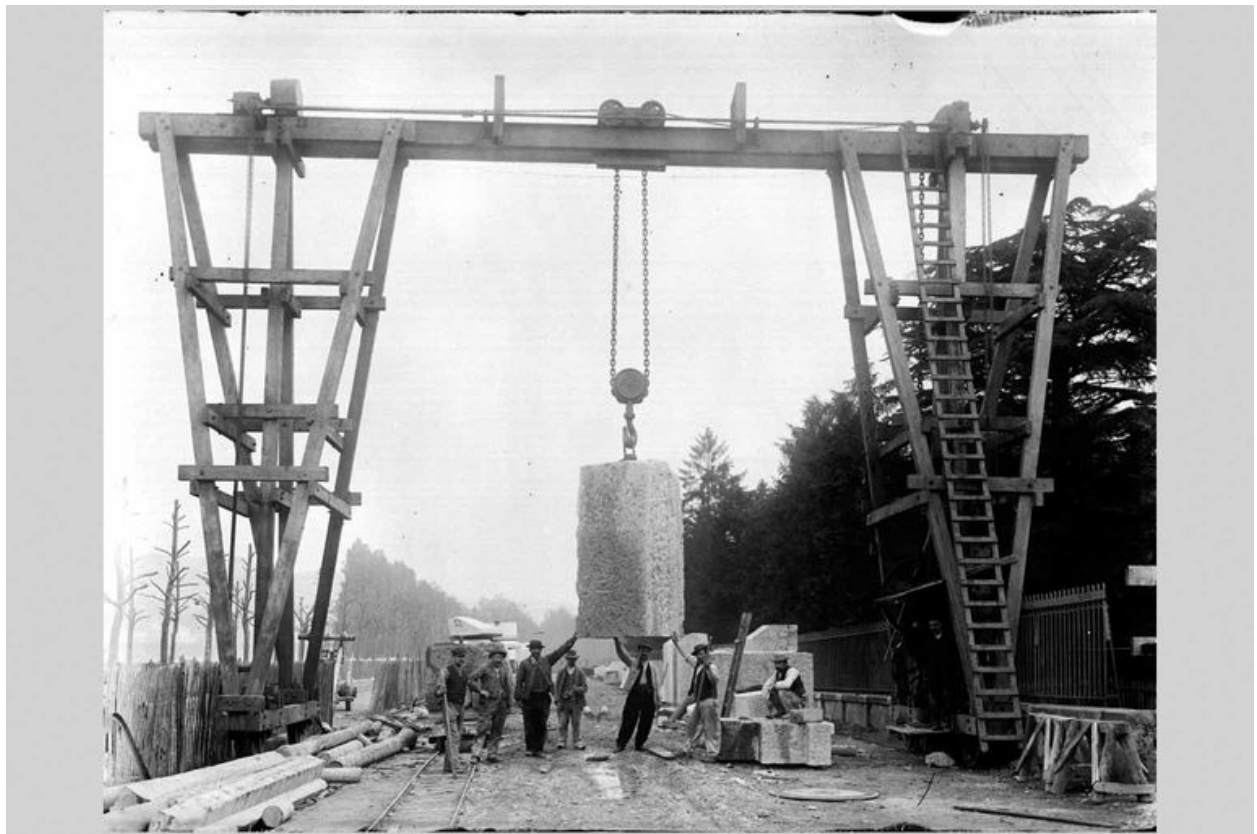
La construction du pont de la Boucle. La pose des maçonneries des piles. Photogr., [1902] (Arch. mun. Lyon. 15 Ph 1799)
