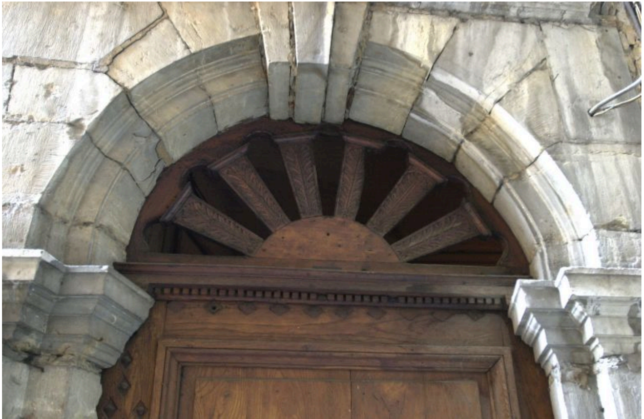
Façade principale, porte, détail du tympan de menuiserie
