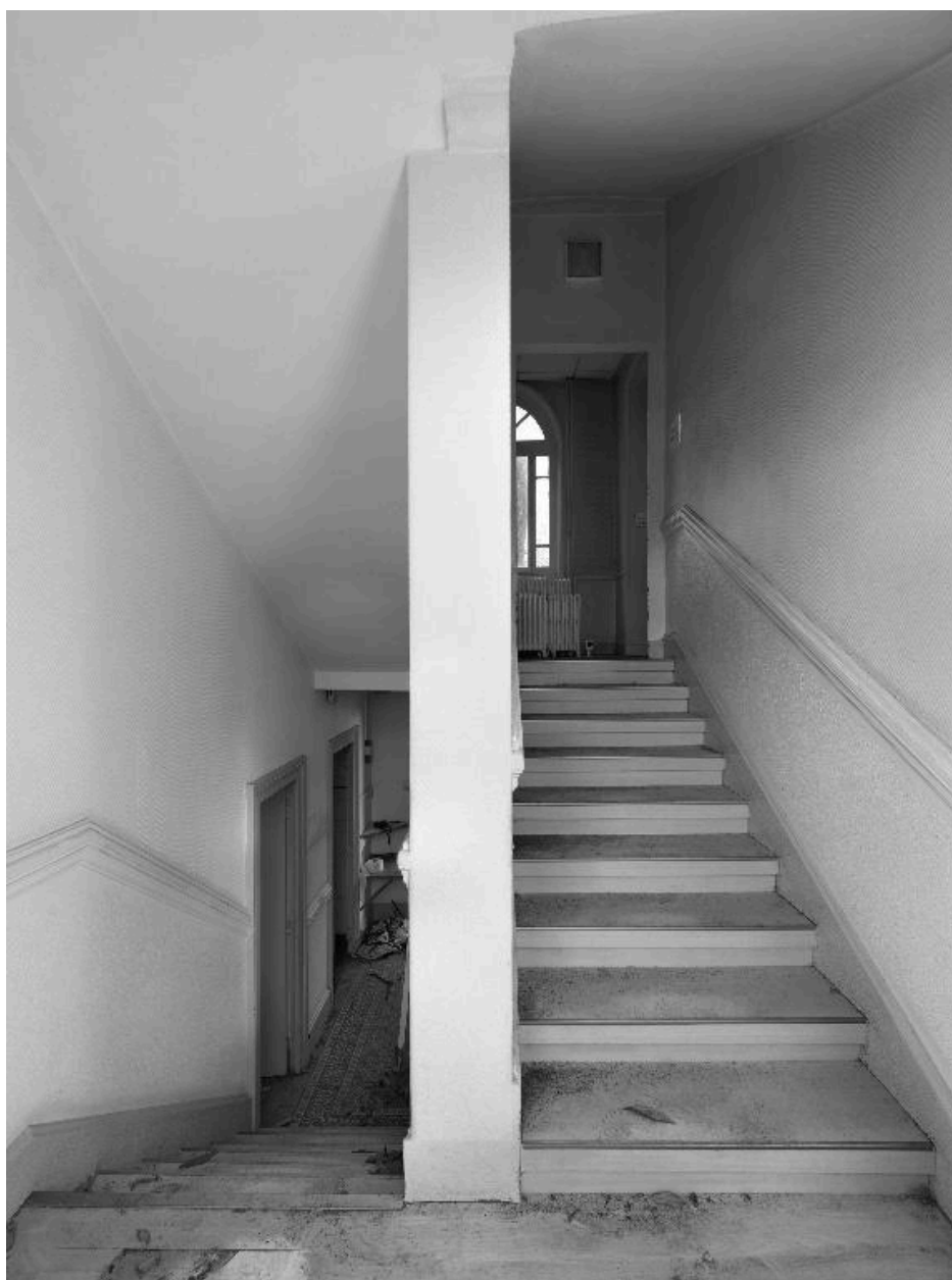
Bâtiment central, escalier à deux volées droites et mur-noyau
