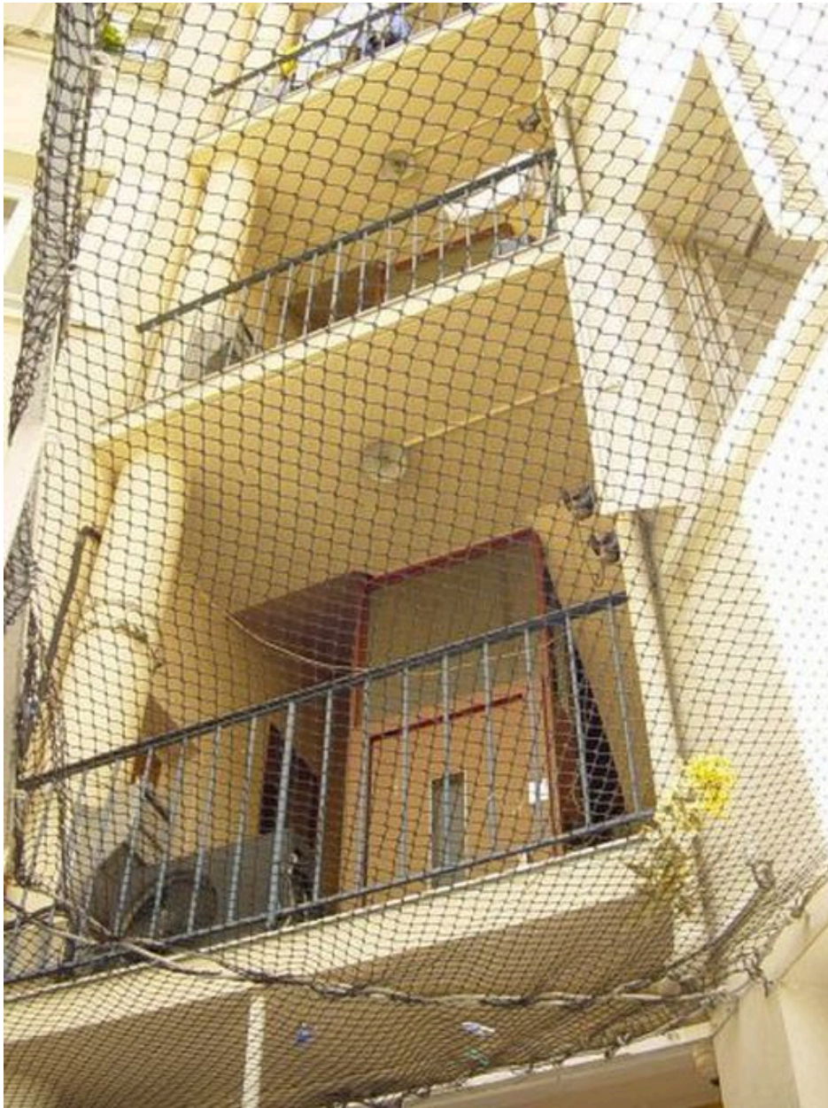
Façade postérieure et ascenseur de service
