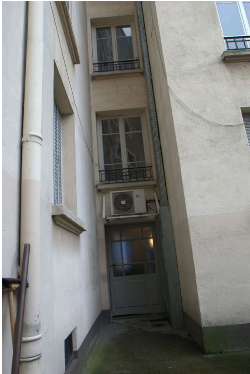
La cage d'escalier et la porte ouvrant sur la cour
