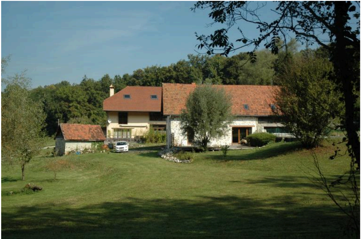
Ferme Chez les Châtel (2016 A2 1391 à 1395), non repérée. Vue depuis le sud.
