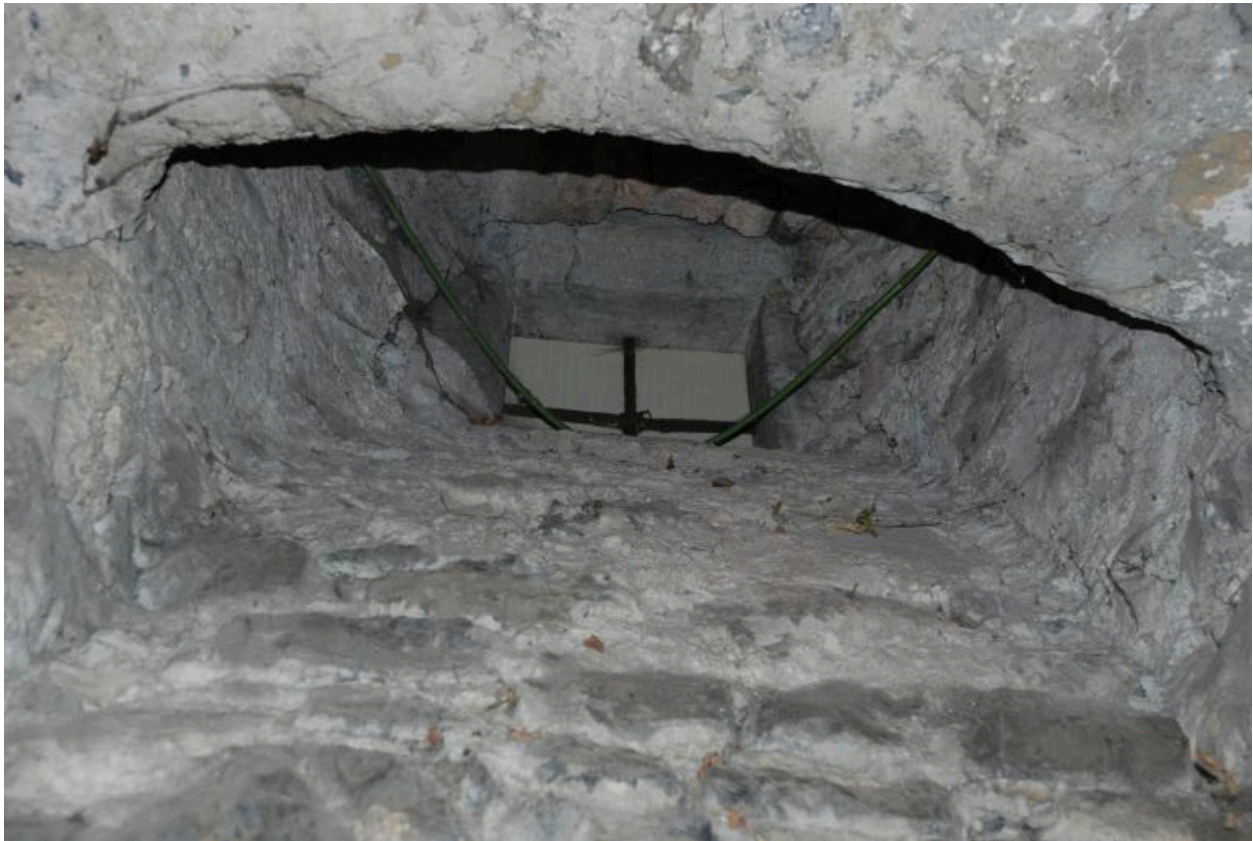
Sous-sol, première cave voûtée en berceau plein-cintre, vue du soupirail contre le mur ouest.
