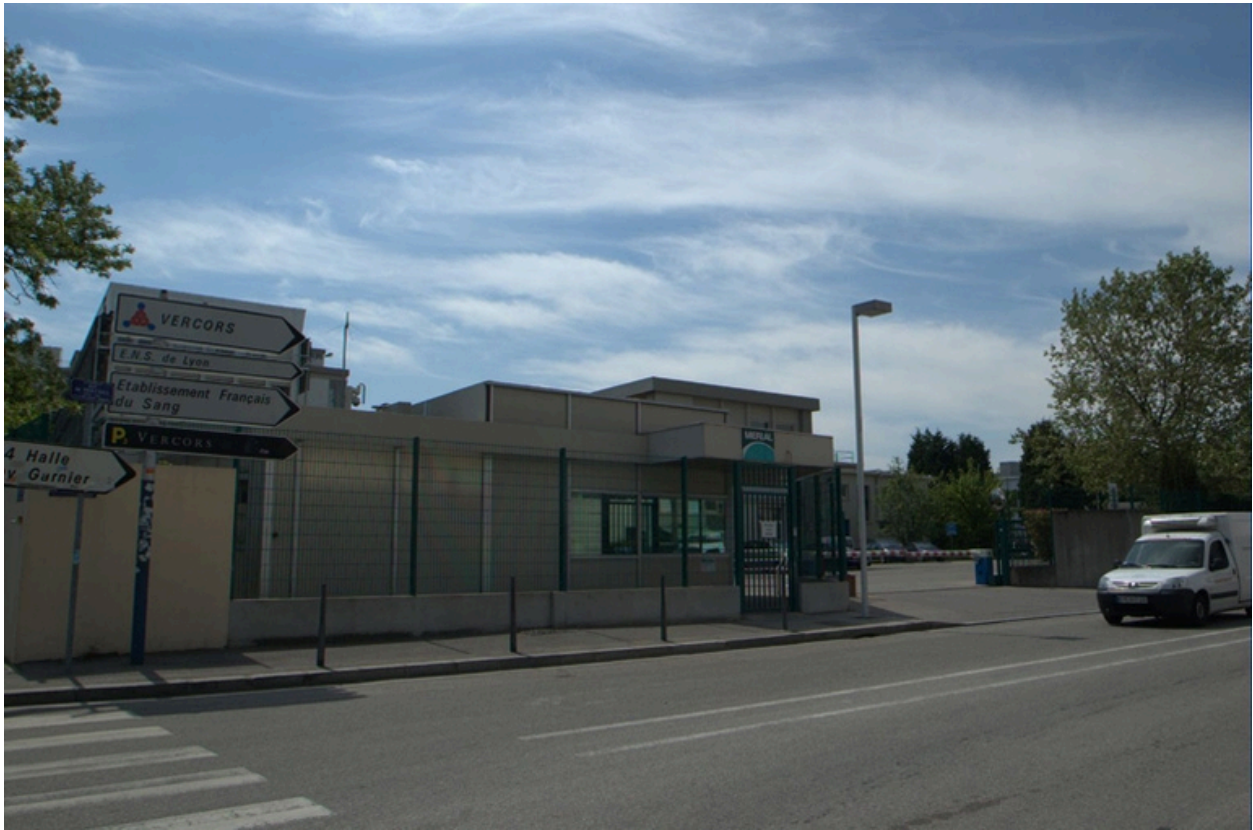
Vue est, rue du Vercors
