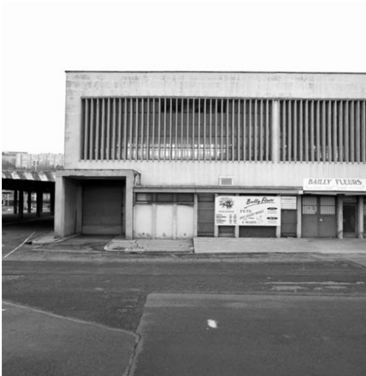
Salle des ventes : vue partielle de l'élévation est
